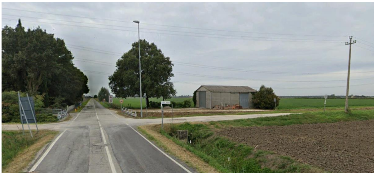
Figura 16 – Percorso del cavidotto esterno in uscita da Via dei Tigli verso Via Canale Bastione (verso destra), in avvicinamento all'area di ubicazione della futura stazione elettrica SE 380/132/36 di Fiscaglia
