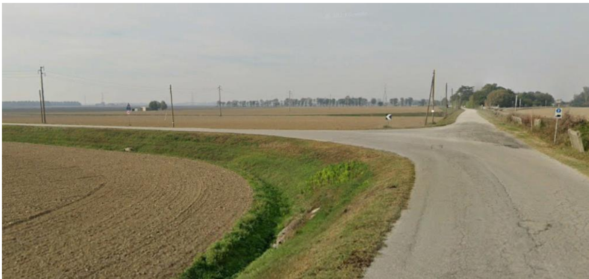
Figura 15 — Percorso del cavidotto esterno sulla viabilità locale Via Guglielmo Marconi
