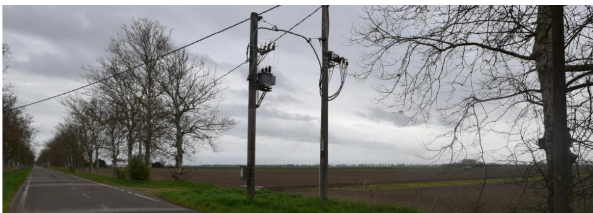
Figura 8 - Inquadramento dell'area d'impianto del campo 4 – Inquadramento da Sud
