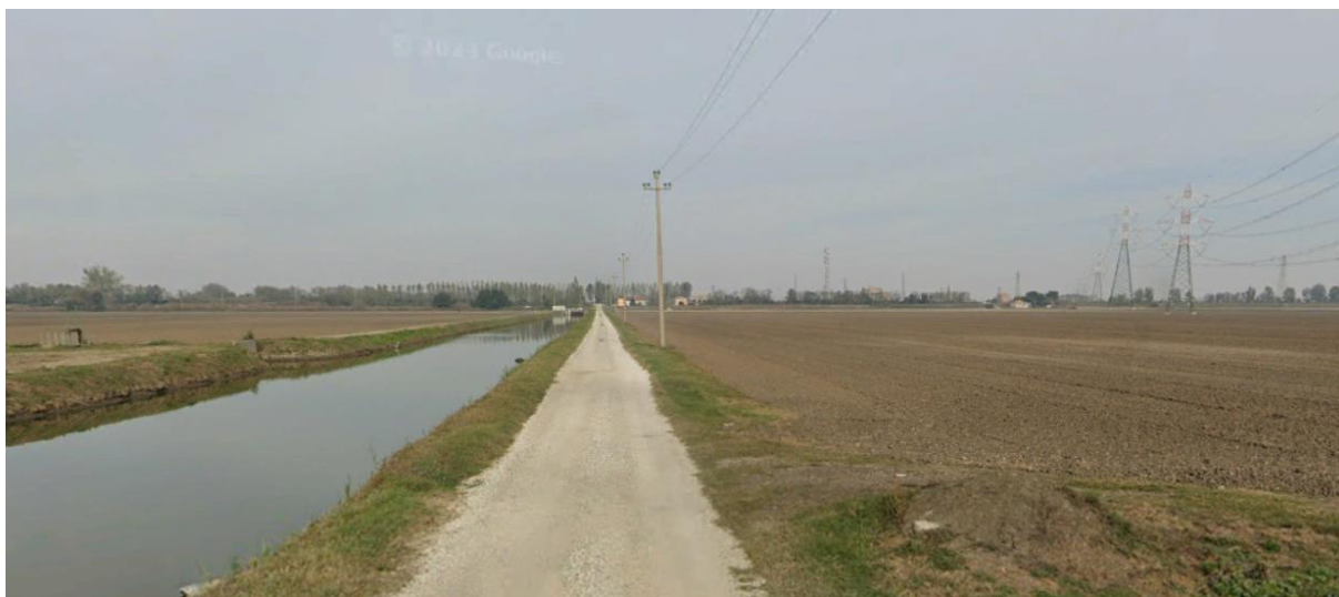
Figura 17 – Percorso del cavidotto AT, adiacente al Canale Bastione, in avvicinamento all'area di ubicazione della futura stazione elettrica SE 380/132/36 di Fiscaglia
