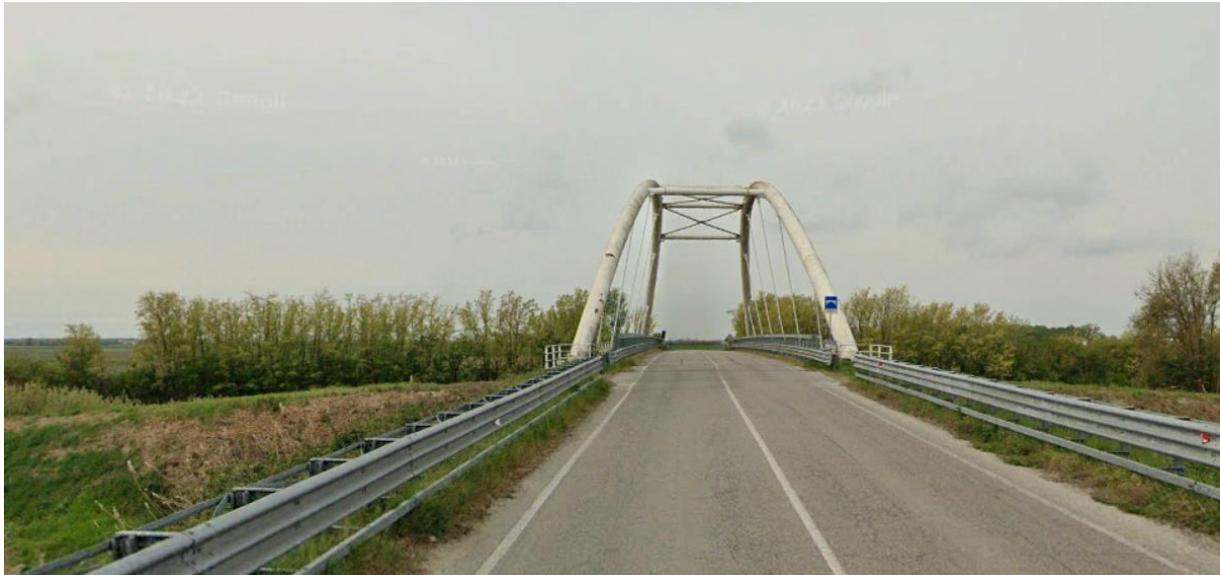
**Figura 14** — Percorso del cavidotto esterno, in attraversamento del collettore Diversivo idraulico Campello, che avverrà mediante staffaggio al ponte esistente, verso la strada locale Zarabotta
