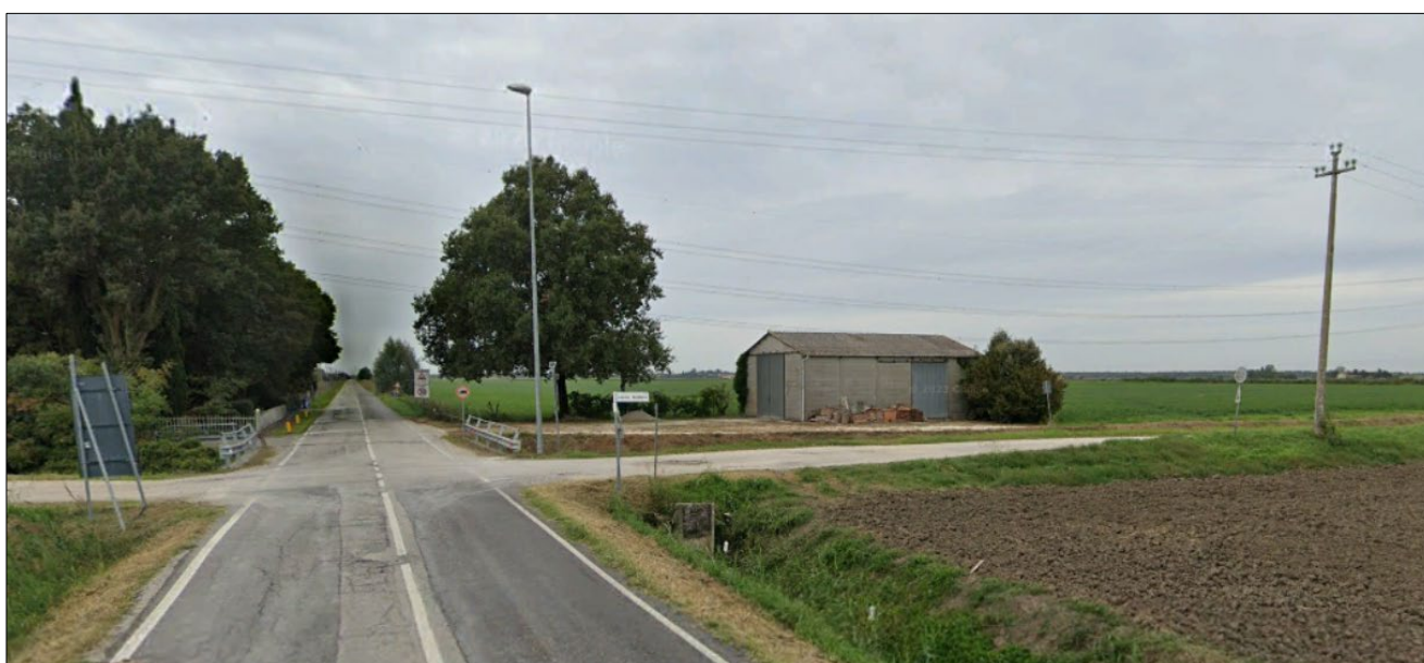
Foto 11 - Percorso del cavidotto AT in uscita da Via dei Tigli verso Via Canale Bastione (verso destra), in avvicinamento all'area di ubicazione della futura stazione elettrica SE 380/132/36 di Fiscaglia
