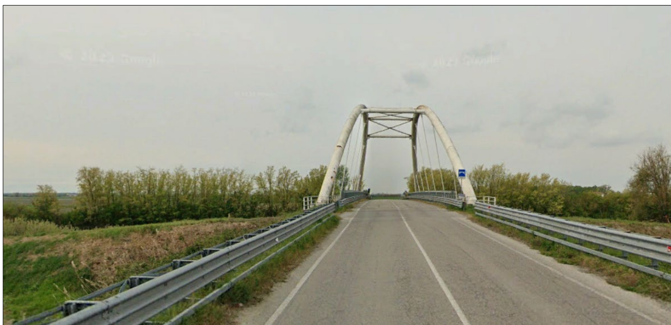
Foto 9 - Percorso del cavidotto AT, in attraversamento del collettore Diversivo idraulico Campello, che avverrà mediante staffaggio al ponte esistente, verso la strada locale Zarabotta
