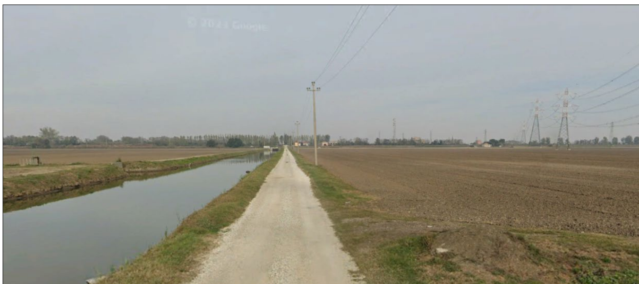
Foto 12 - Percorso del cavidotto AT, adiacente al Canale Bastione, in avvicinamento all'area di ubicazione della futura stazione elettrica SE 380/132/36 di Fiscaglia
