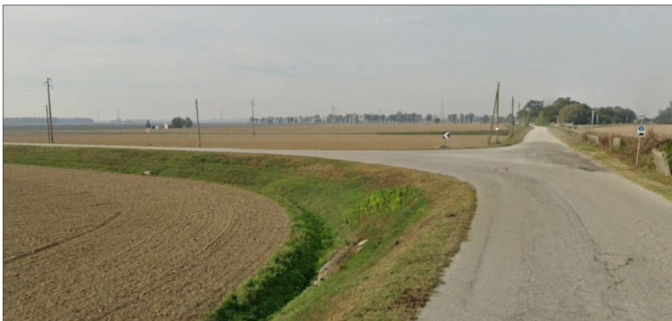
Foto 10 - Percorso del cavidotto AT sulla viabilità locale Via Guglielmo Marconi
