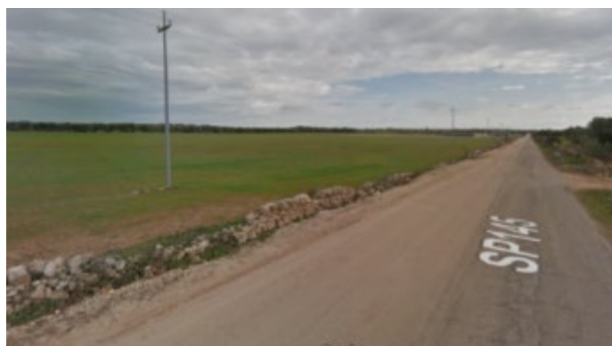
Figura. Linea Elettrica MT Aerea interferita presso la SP 145
