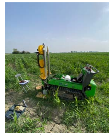
Sondaggio DPSH – P5
