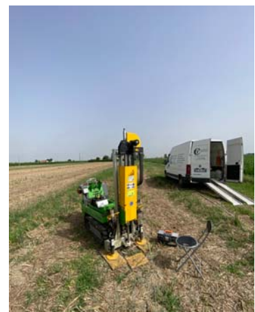
Sondaggio DPSH – P6
