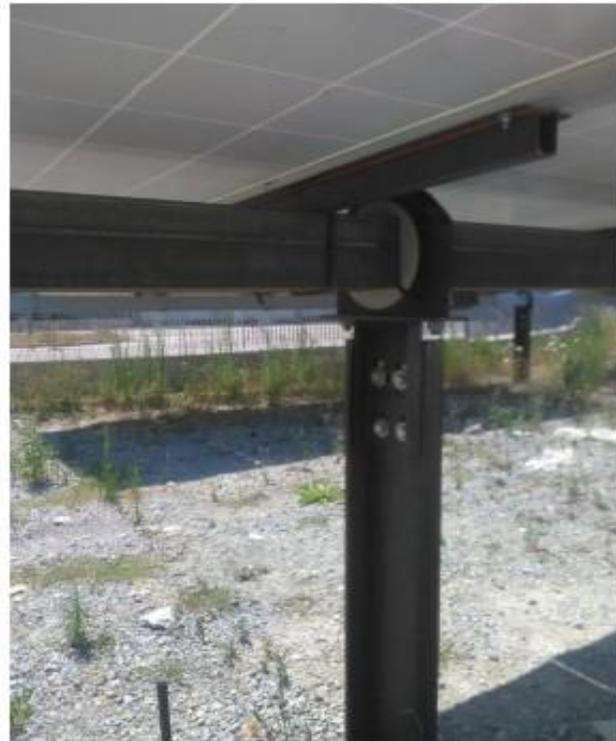
*FIGURA 26. Dettaglio del cuscinetto del tracker che rende possibile la variazione dell'inclinazione*
