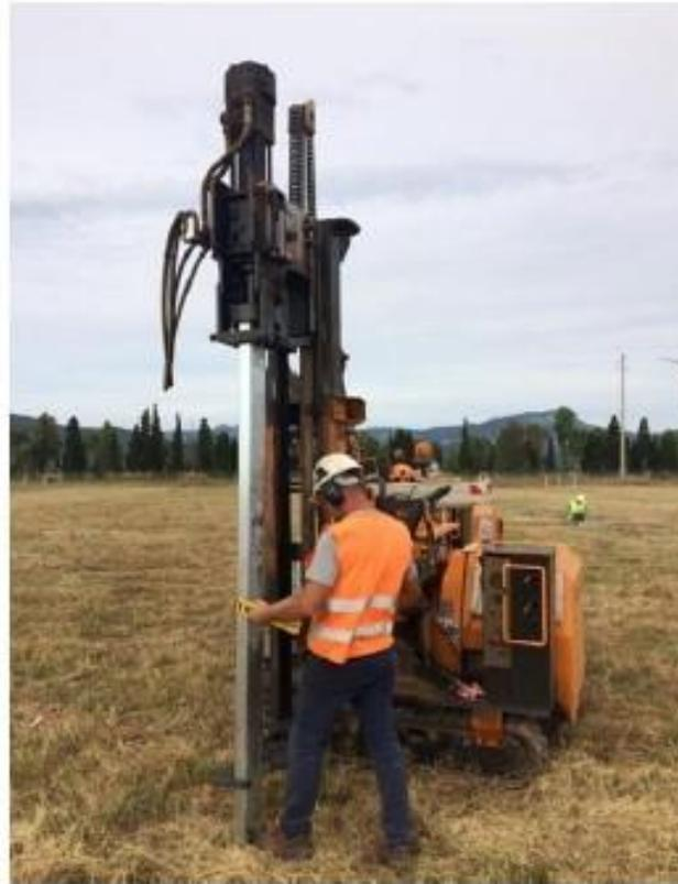
*FIGURA 25. La macchina battipalo per l'infissione nel terreno dei profilati metallici*
