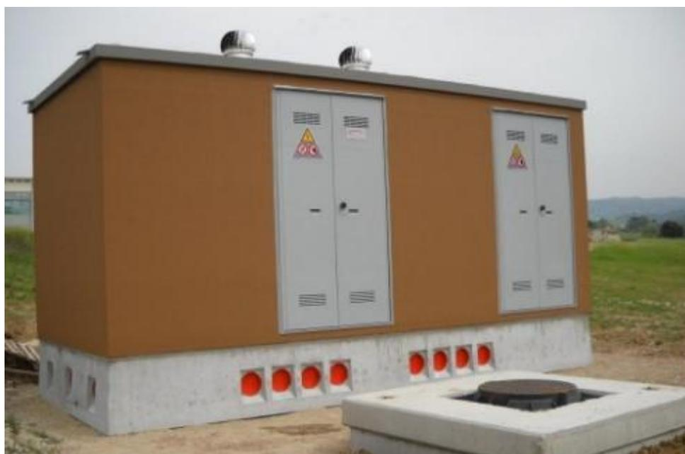
*FIGURA 30. Foto di un esempio delle cabine prefabbricate dell'impianto in c.a.v. (che potranno essere alternativamente utilizzate alle cabine prefabbricate in metallo di cui alla Figura 35)*
