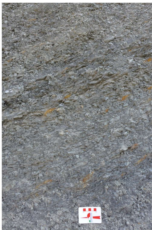
Figura 10 - Dettaglio dello stato di fratturazione dell'ammasso roccioso in prossimità di un piano a basso angolo, sviluppato nella formazione di rigoroso.
