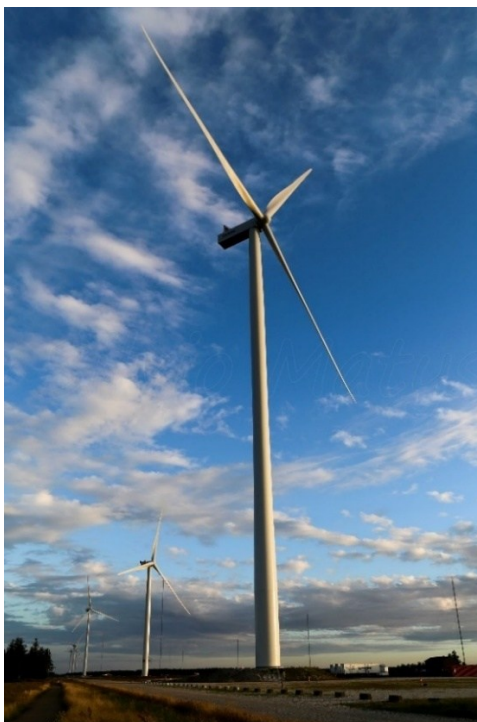
Figura 3 – Aerogeneratore Vestas V150
