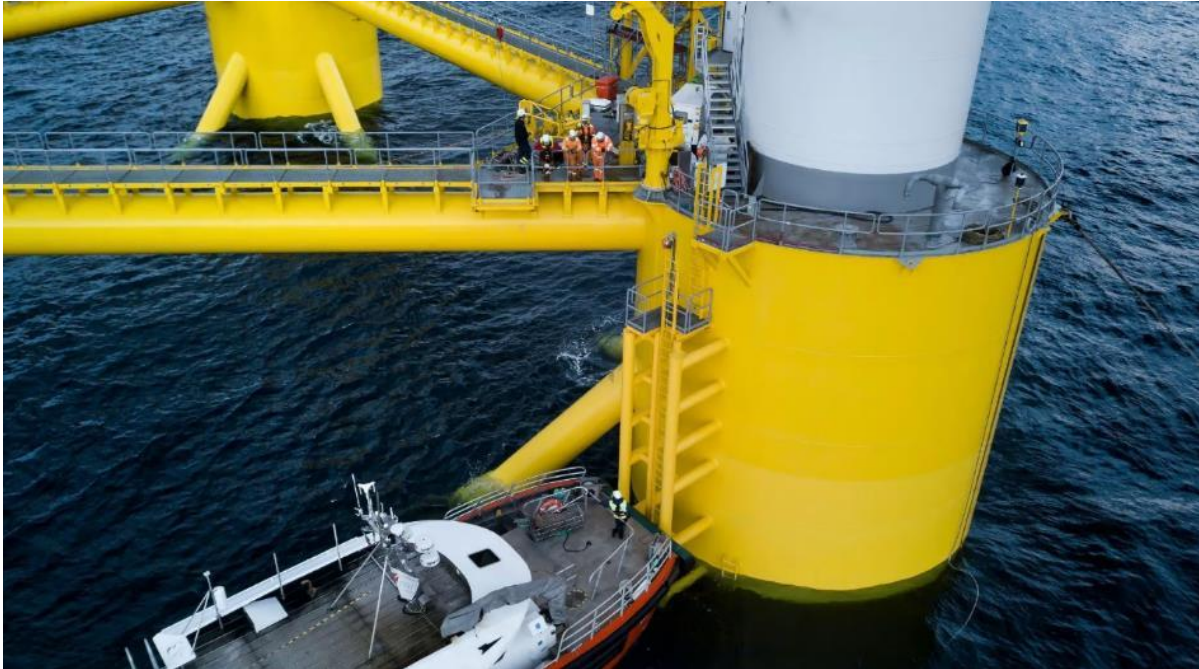
Figura 7-4 – Personale impegnato nella manutenzione della fondazione galleggiante della turbina (Kinkardine)
