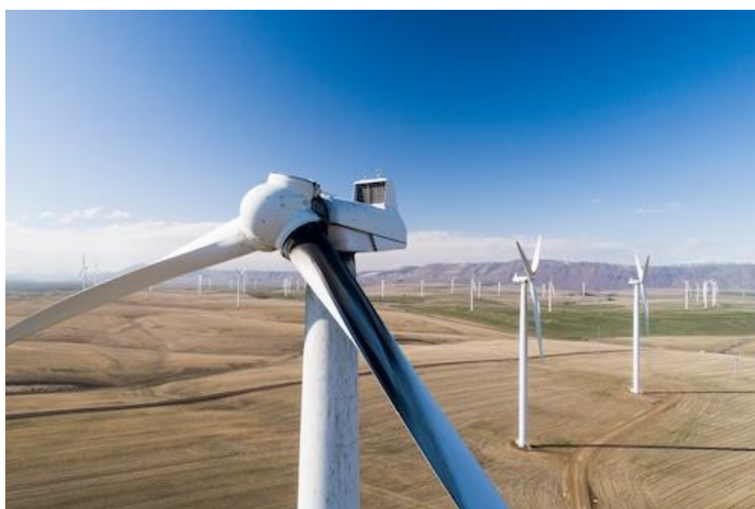
Figura 5-2 – Rottura della pala completa con distacco dal rotore (Parco eolico PGE in Sherman County)
