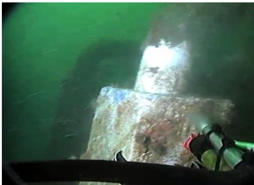
Figura 12 – Rimozione dello strato di biofouling tramite getto d'acqua ad alta pressione attaccato al ROV
