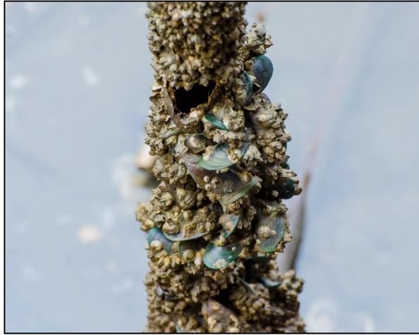
Figura 8 – Strato esterno di incrostazioni dovute al biofouling
