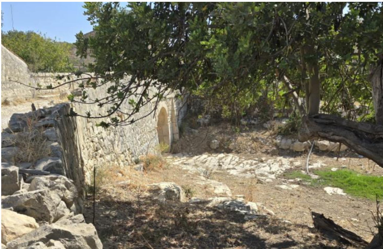
Figura 4-7 –Vista del ponte in roccia che supera il piccolo corso d’acqua intermittente.
