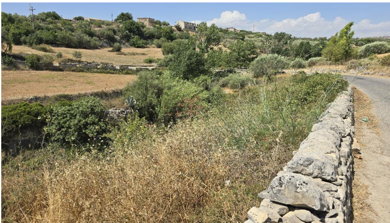
Figura 4-9 – Vista della valle incisa del fosso e sullo sfondo il ponte stradale (vista da valle verso monte).
