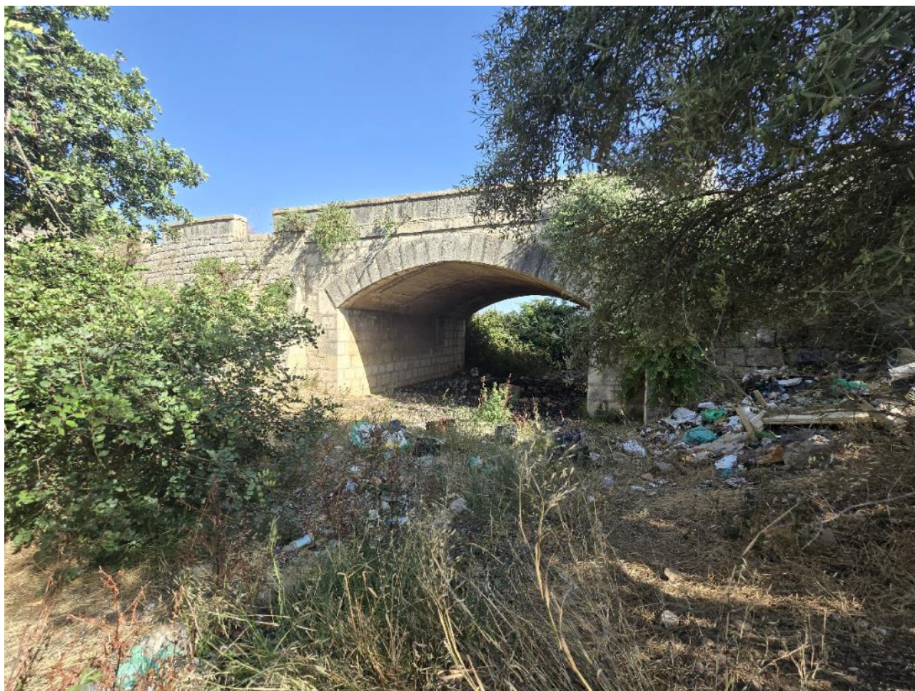
Figura 4-3 – Ponte di attraversamento della Cava Tadarita visto da monte.
