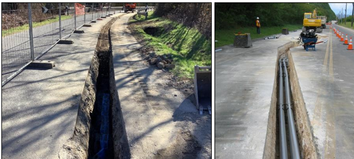
Figura 2-8 Esempio di scavo per interrimento su asfalto
