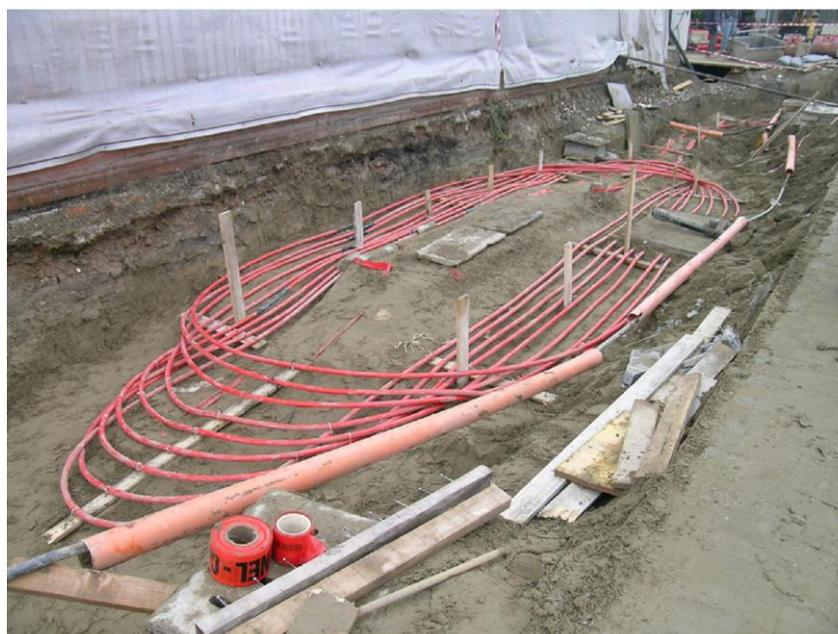
Figura 6-3: esempio di installazione di loop passivi in corrispondenza della buca giunti
