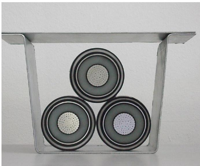
Figura 6-6: Esempio di installazione cavi AT in canale schermante
