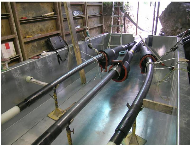
Figura 6-4: esempio di installazione buca giunti in canale schermante
