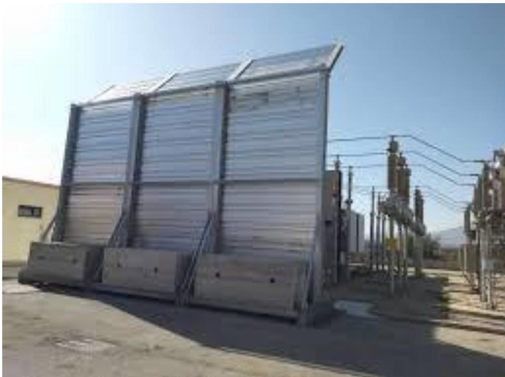
Figura 6-2: Esempio di barriera fonoassorbente di cantiere temporanea (rif. Bosco Italia)
