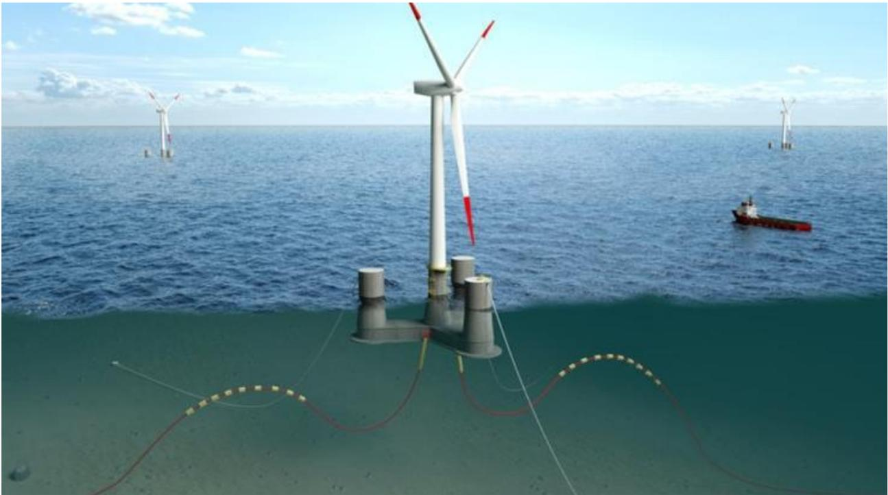
Figura 4-2: Struttura di galleggiamento della turbina
