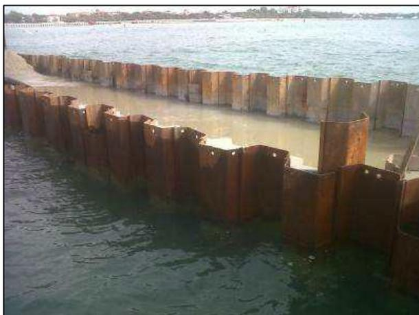
Figura 3-41: Postazione di recupero con palancole per il contenimento e il recupero dei fanghi di perforazione
