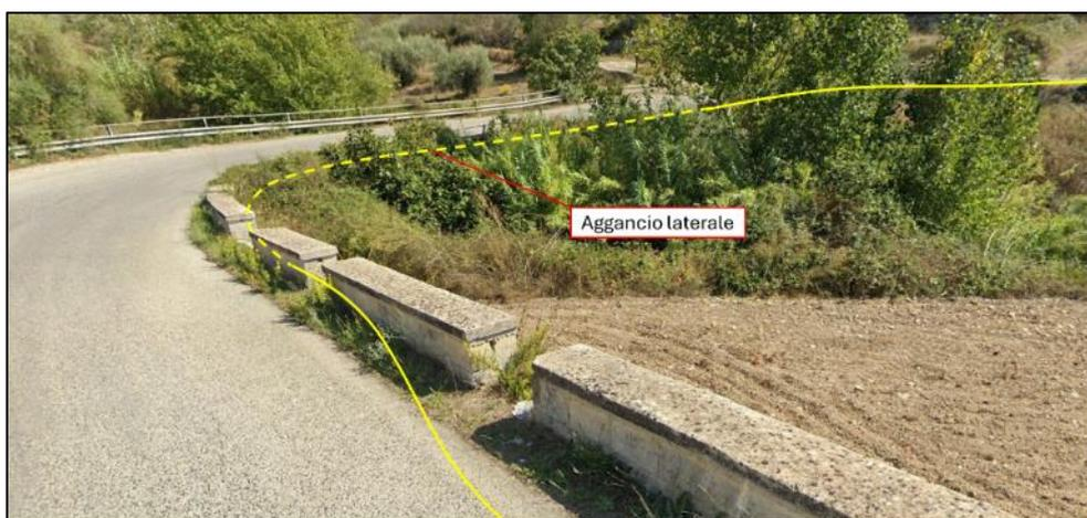
Figura 3-21: Superamento mediante canalizzazione di un impluvio
