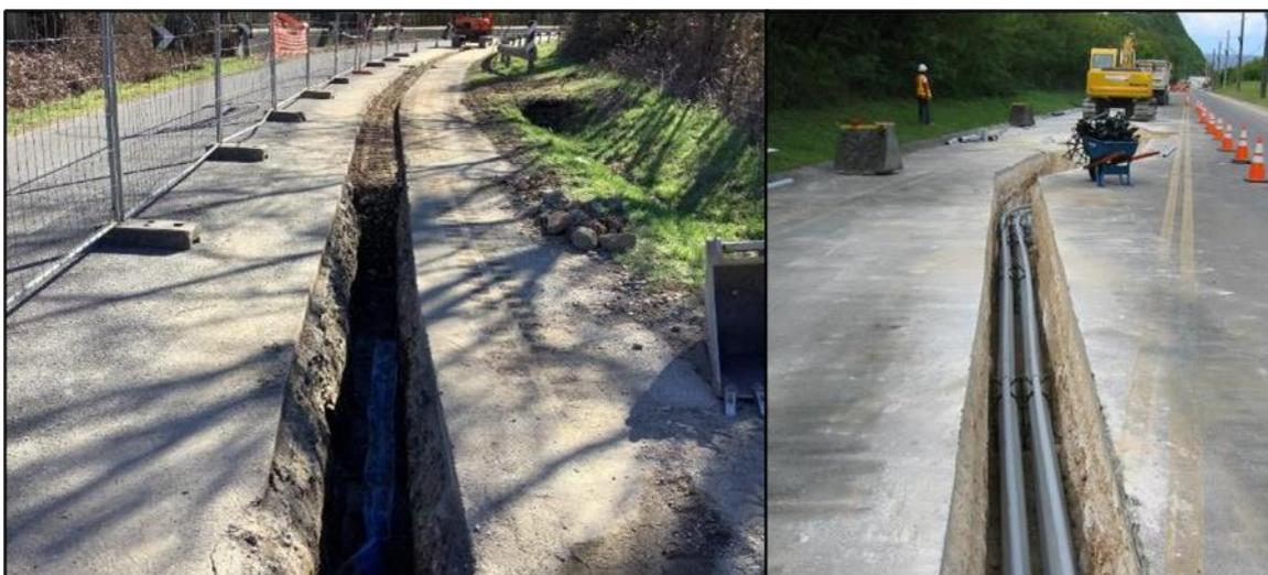
Figura 3-44: Esempio di scavo per interrimento su asfalto
