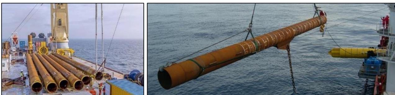
Figura 3-49: Esempio di trasporto e calo a mare dei pali di ancoraggio
