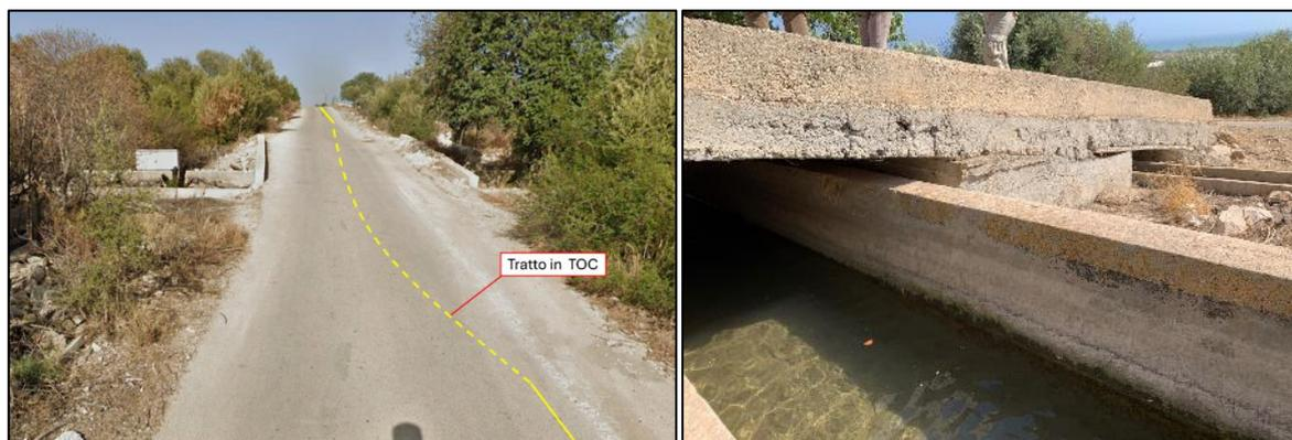
Figura 3-17: Superamento in TOC di un canale minore
