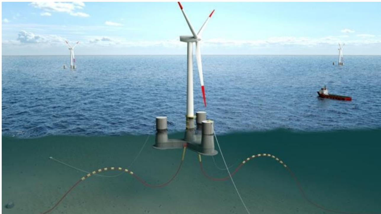
Figura 3-27: Struttura di galleggiamento della turbina
