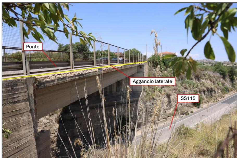
Figura 3-22: Superamento mediante canalizzazione della SS115
