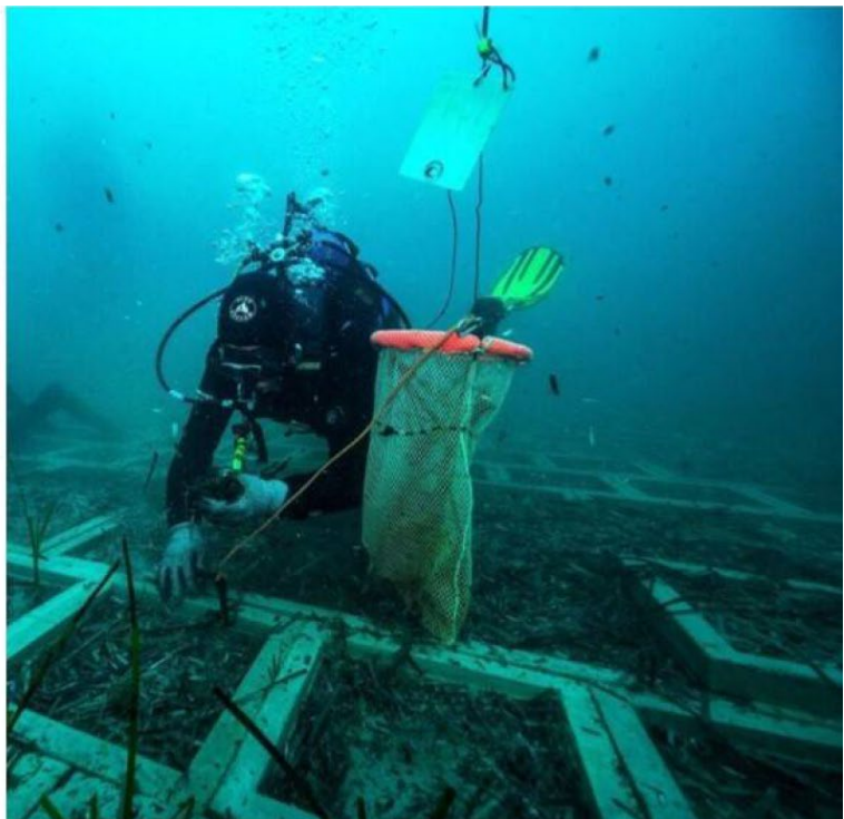
Materassi zavorrati per la creazione di substrati biocenotici
