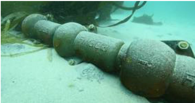
Posa del cavidotto marino in corrispondenza della prateria di Cymodocea nodosa (passaggio TOC-Appoggio)
