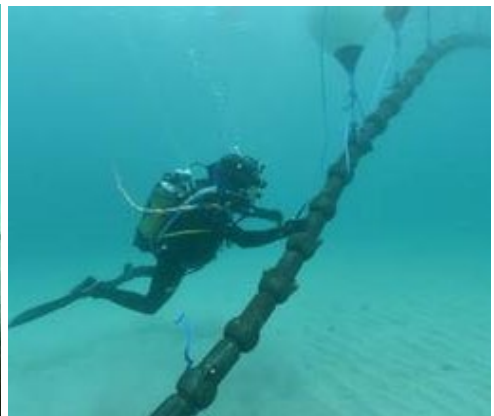
Posa del cavidotto marino in corrispondenza della prateria di Cymodocea nodosa (passaggio TOC-Appoggio)
