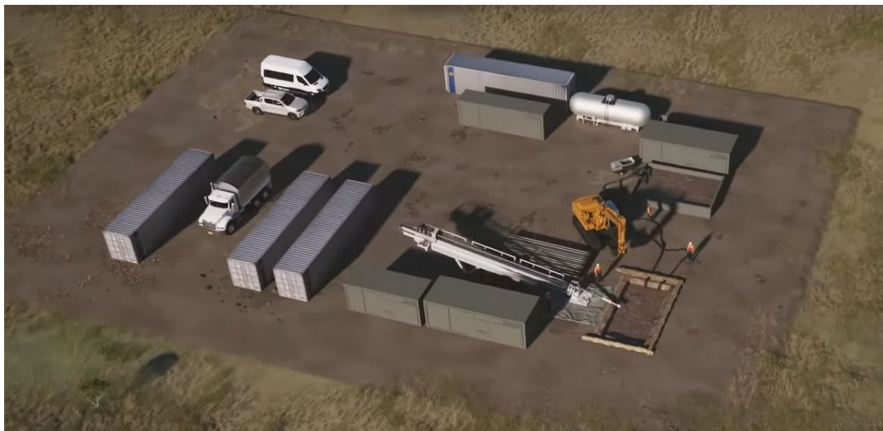
Trivellazione orizzontale controllata, il cantiere base a terra
