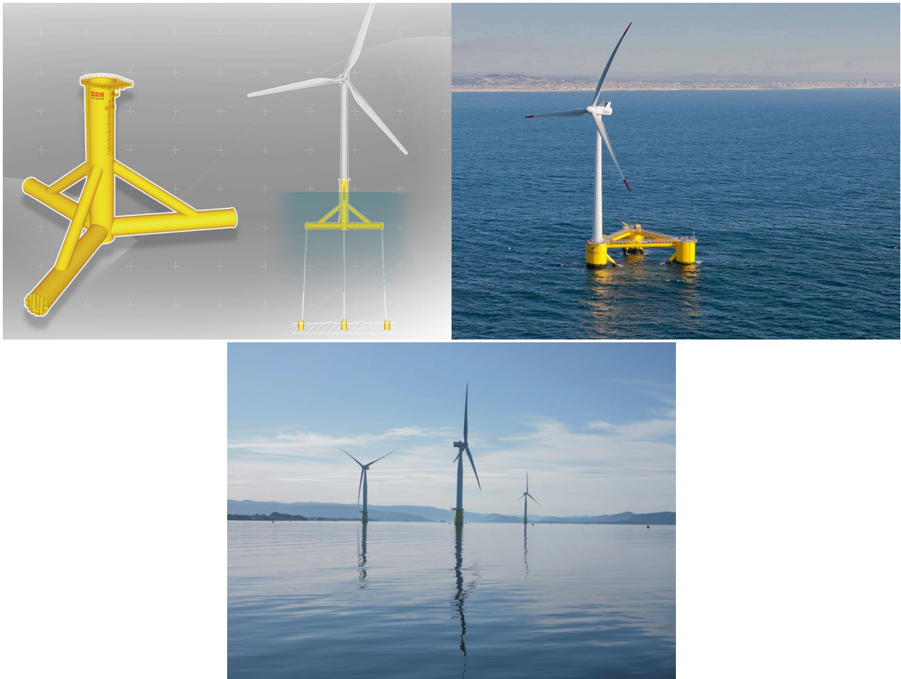
Figura 11: (in alto) SBM Offshore TLP 8 , (in basso a sinistra) semisommersibile 9 di Principle Power, (in basso a destra) lo spar di Hywind 10
