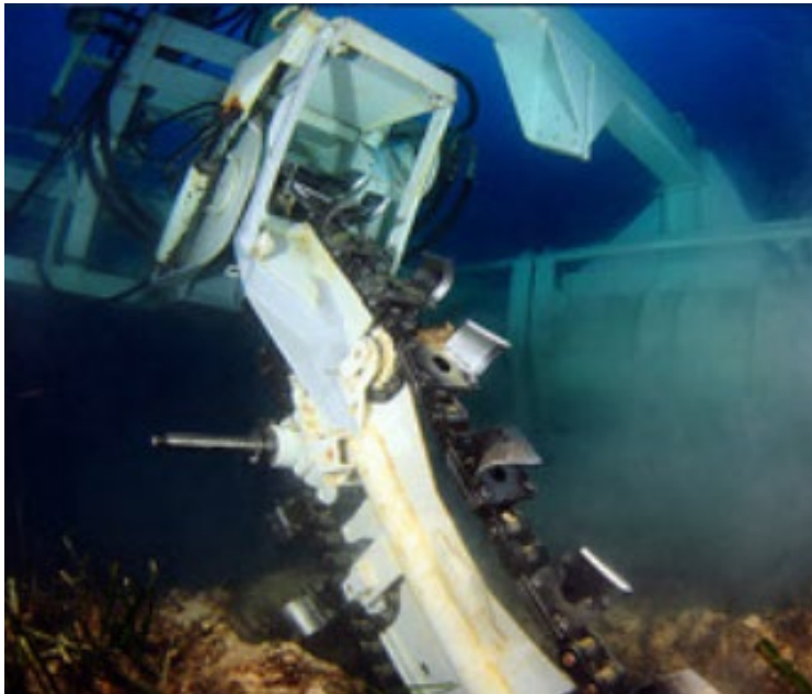
Il trenching chirurgico – esecuzione con aratro a pilotaggio manuale
