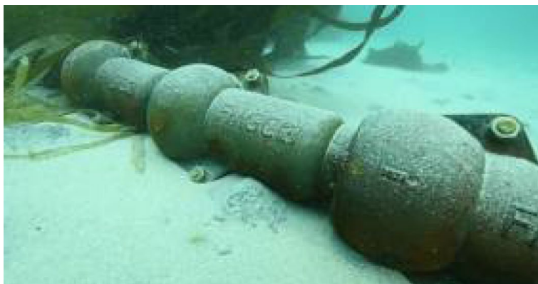
Posa del cavidotto marino in corrispondenza della prateria di Cymodocea nodosa
