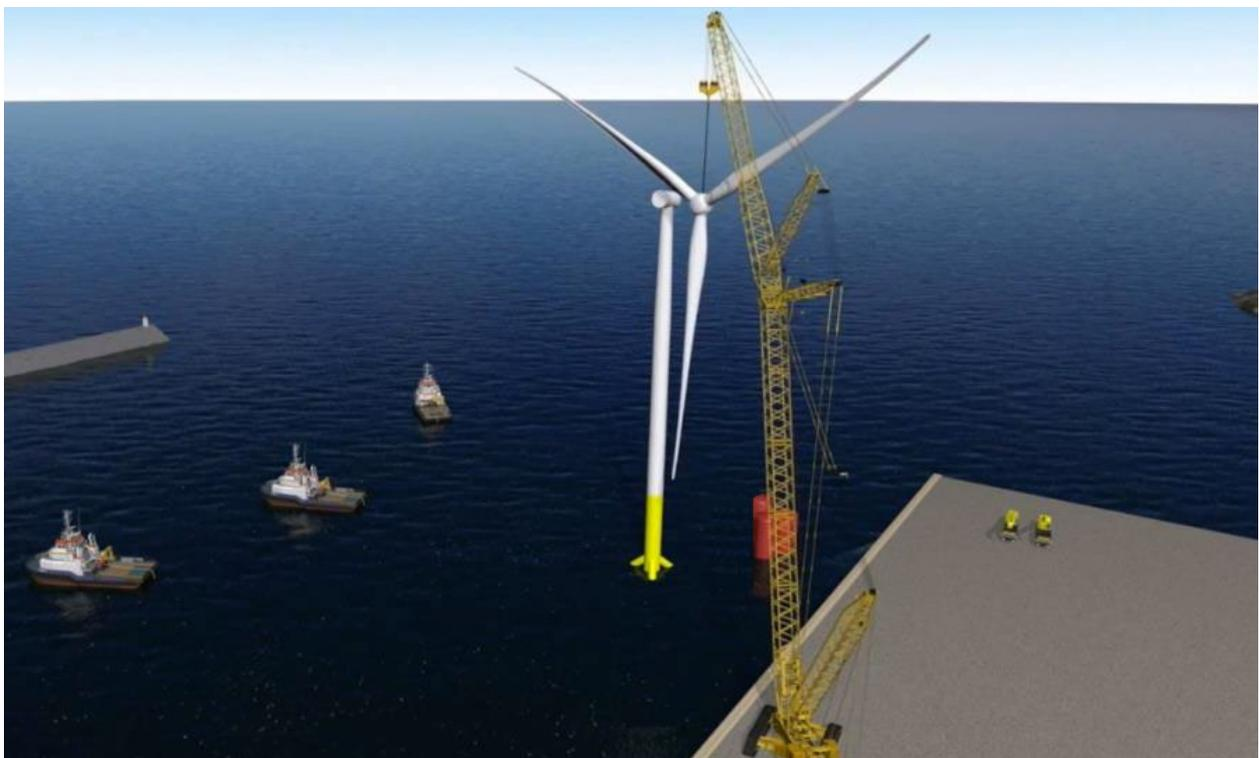
*Montaggio di un aerogeneratore in banchina*
