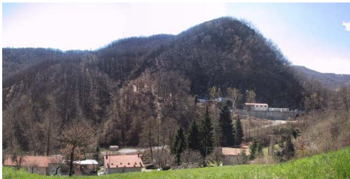
Fig 1.1.A Contesto vegetazionale in cui è inserita la strada di accesso al pozzo Finestra Castagnola
