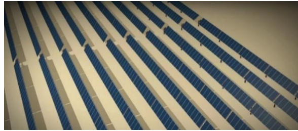
Figura 5-1– Esempio di inseguitore monoassiale
