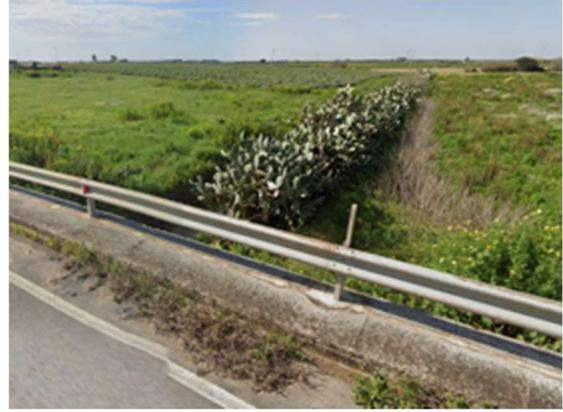
Per non interferire con le fondazioni del ponte di attraversamento del "Canale Pandi", verrà predisposto un percorso laterale per il passaggio del cavidotto di interconnessione con la tecnica della Trivellazione Orizzontale Continua (T.O.C.).
