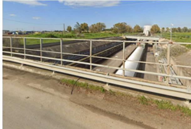
Per non interferire con le tubazioni della centrale termoelettrica Federico II, il passaggio avverrà attaccandosi al cavalcavia e non andando interrati.
