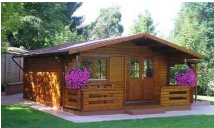
Esempio di struttura in legno da adibire ai fini didattici
