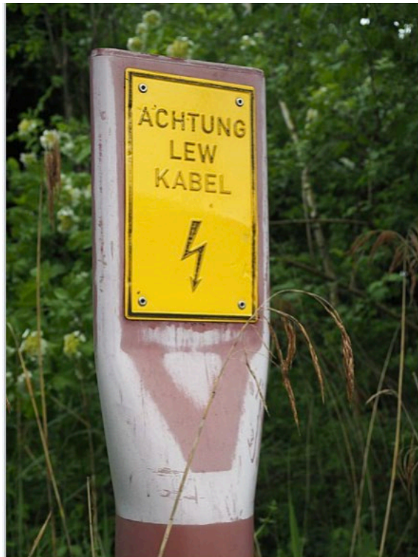
Segnale di avvertimento per la presenza di cavi elettrici interrati ad alta tensione .
