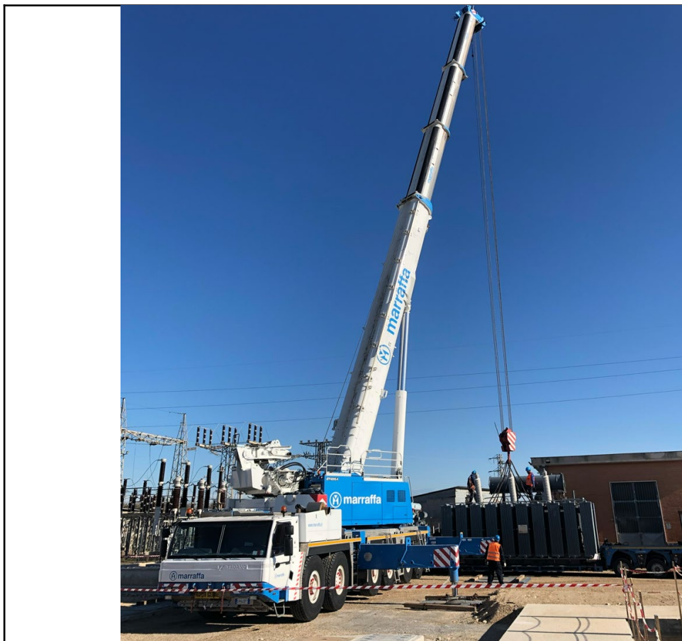
Scarico con autogru
