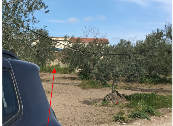
Fabbricato collabente più vicino alla linea
