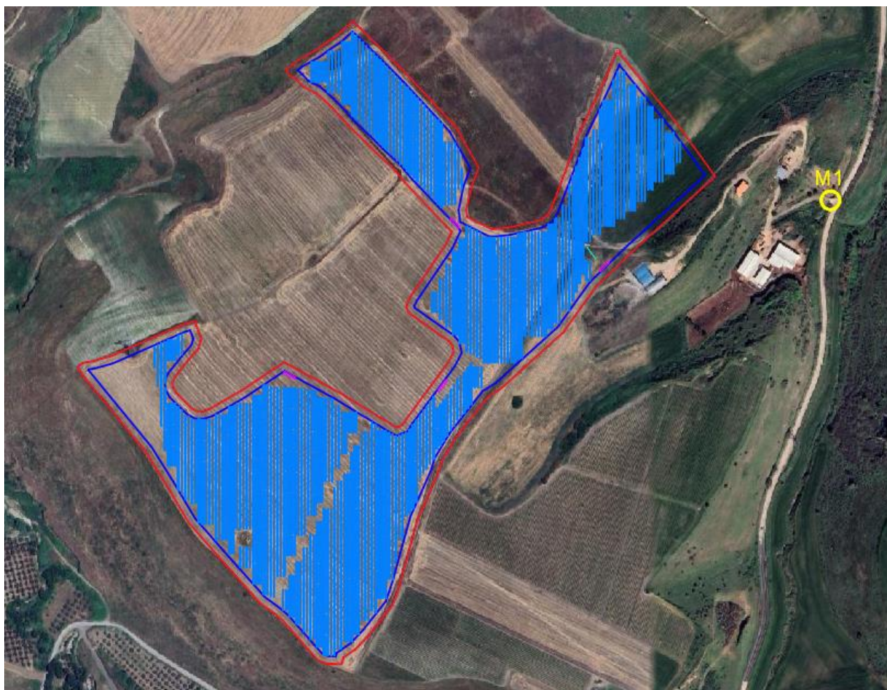
Figura 8 – Ubicazione delle postazioni di misura effettuate
