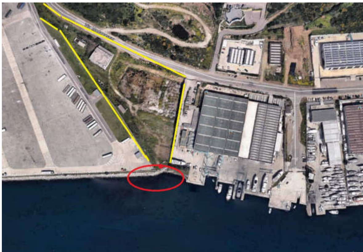
Fig.2 - Foto zenitale area intervento
