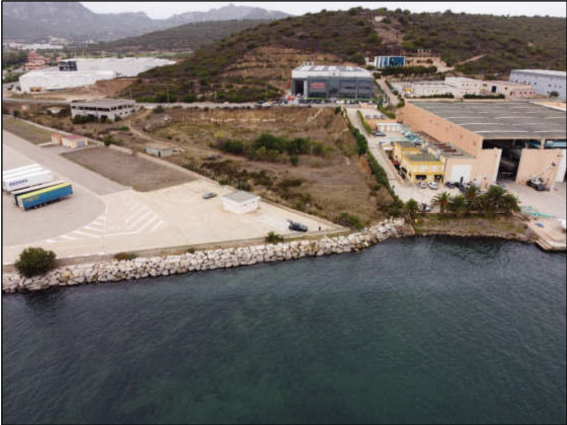
Vista aerea N. 01 area intervento
