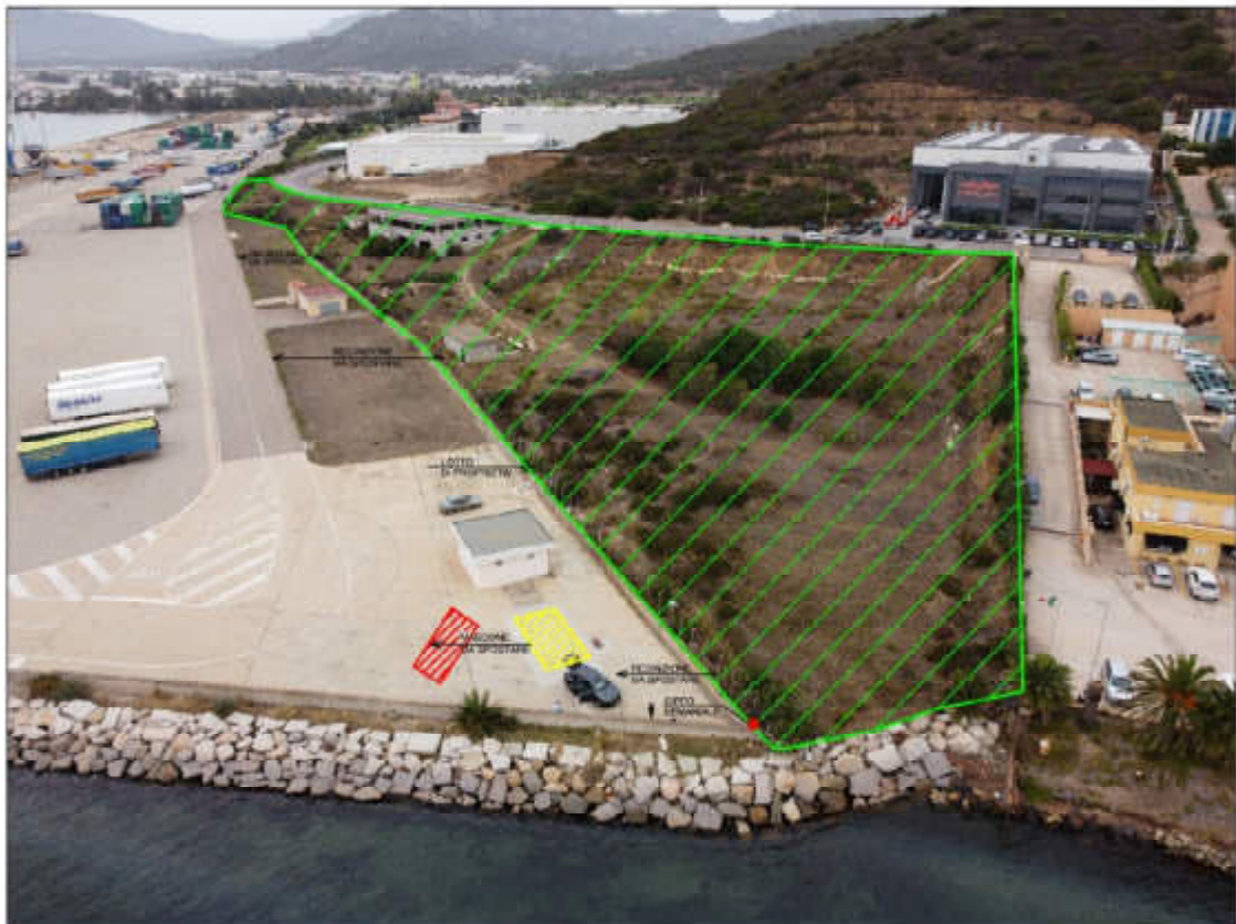
Vista aerea N. 02 area intervento
