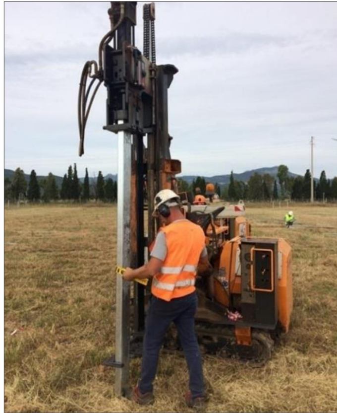
Figura 19: infissione delle strutture
