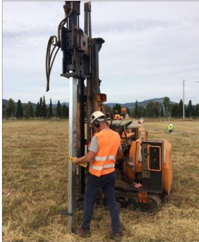
Figura 19: infissione delle strutture
