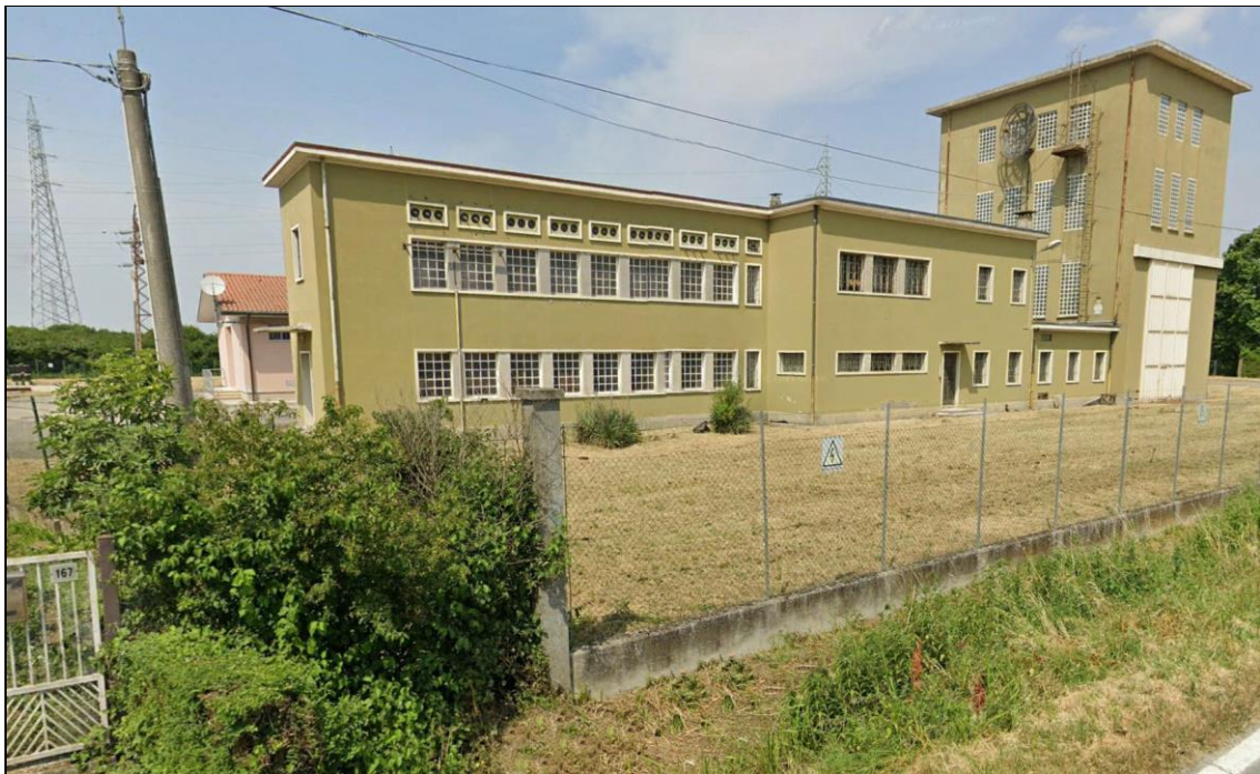
Figura 12: cabina Ca Tron
