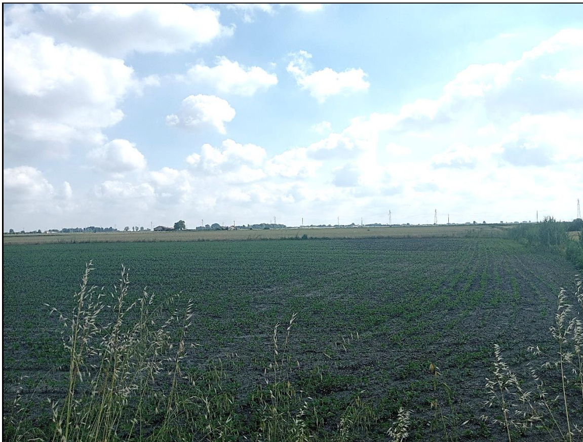
Foto 1: area impianto "A"
