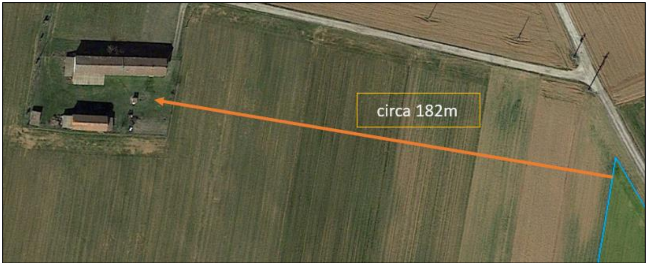
Fig. 14: Recettore G, vista aerea e distanza dall'impianto Agrovoltaico
