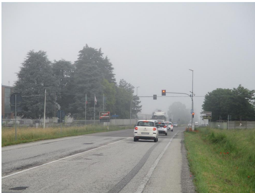
Fig. 3: Foto n° 1: Incrocio con linea elettrica aerea (44°49'36.9"N, 8°44'43.4"E)
