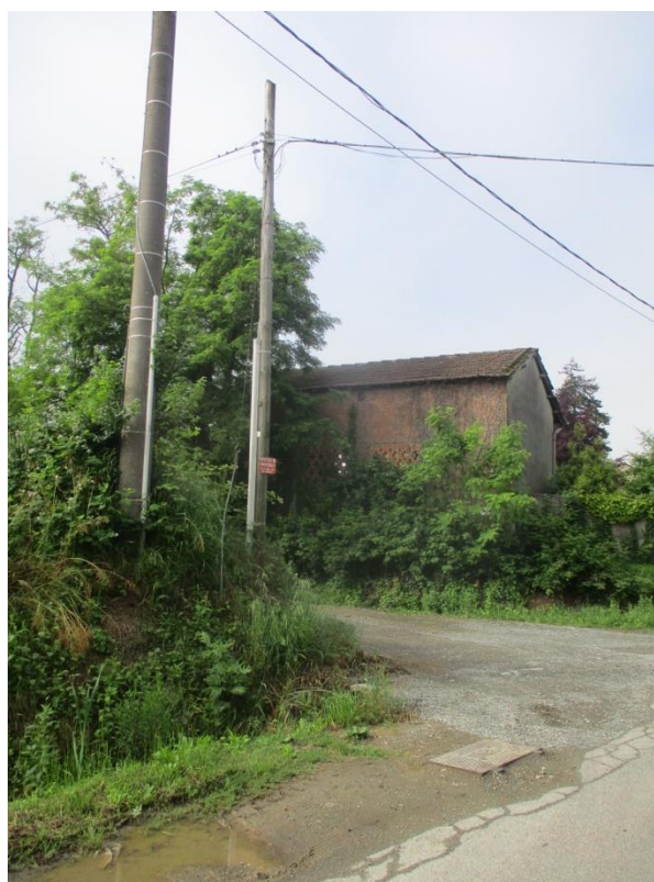
Fig. 10: Foto n° 8: Incrocio con canale di scolo superficiale e cavi elettrici interrati (44°49'12.5"N, 8°43'06.0"E)
