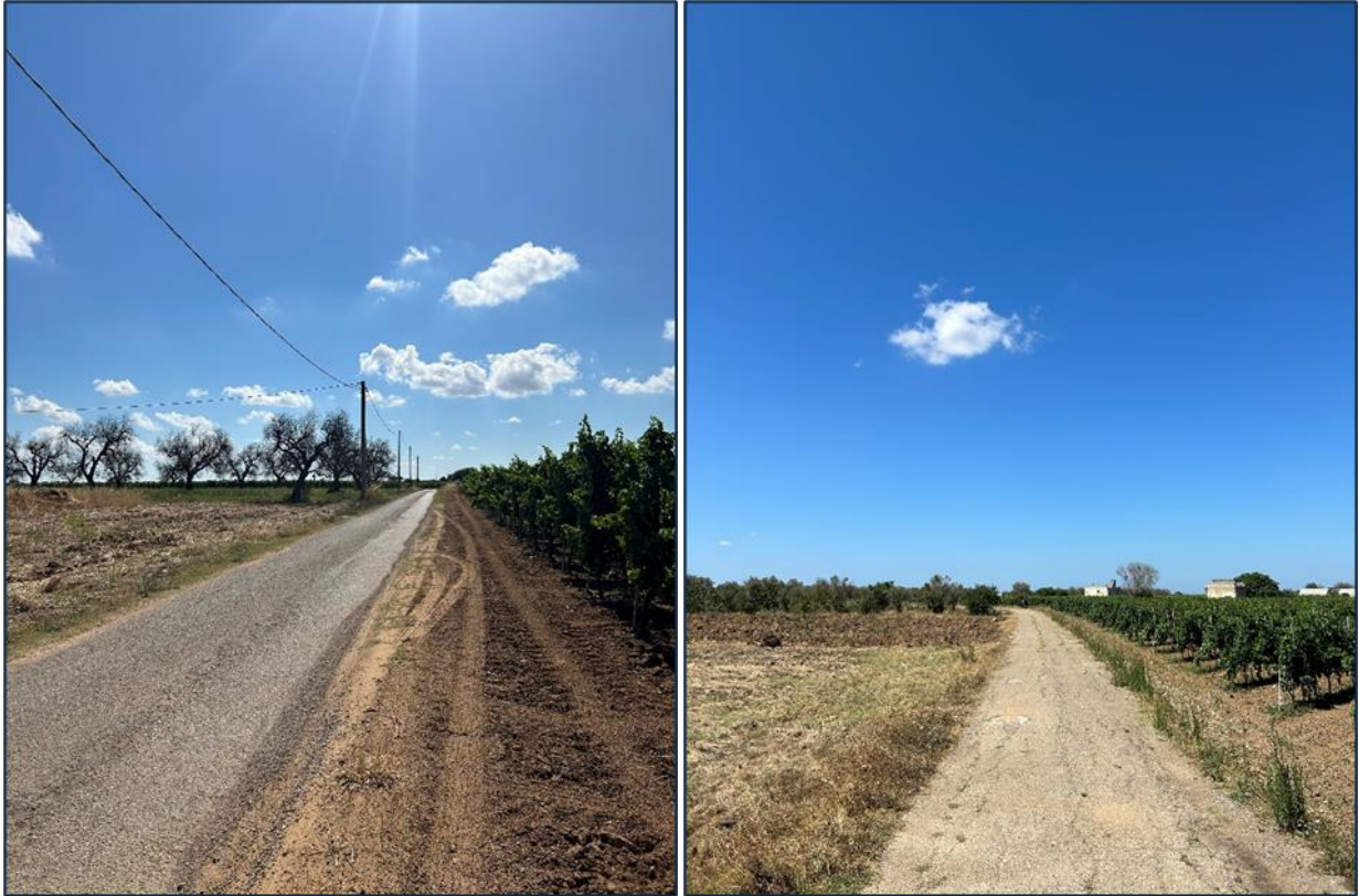
Foto 33-34: Viabilità percorsa dal cavidotto esterno ed interno
