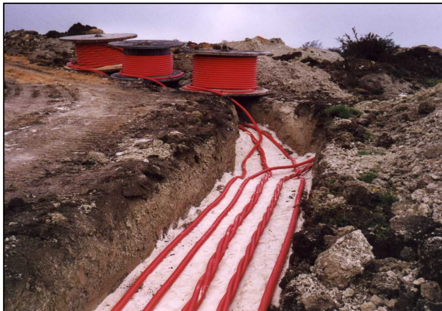
Figura 1.4.7.-1.: Particolare della posa cavi elettrici.
