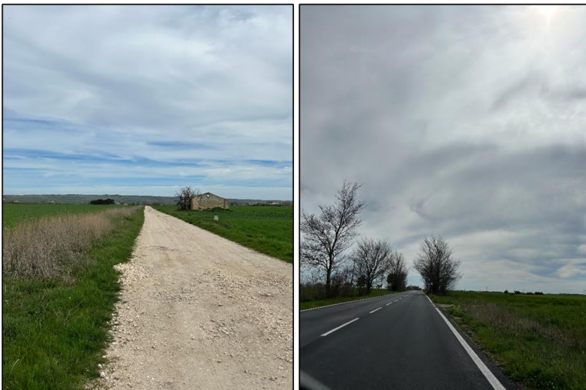
Foto 13-14: Viabilità provinciale e poderale presente in prossimità dell'area di progetto
