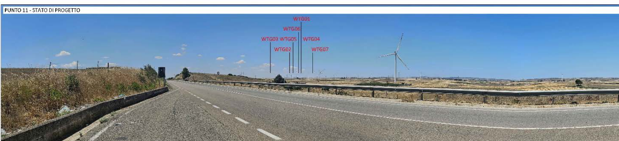
Confronto tra stato di fatto e stato di progetto: punto di presa 11
