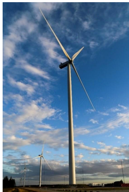
Fig. 2 Aerogeneratore Vestas V150
