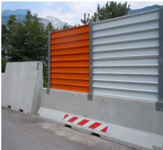
**Figura 13-7: Esempio di barriera mobile altezza 2 m montata su basamento in cls**
