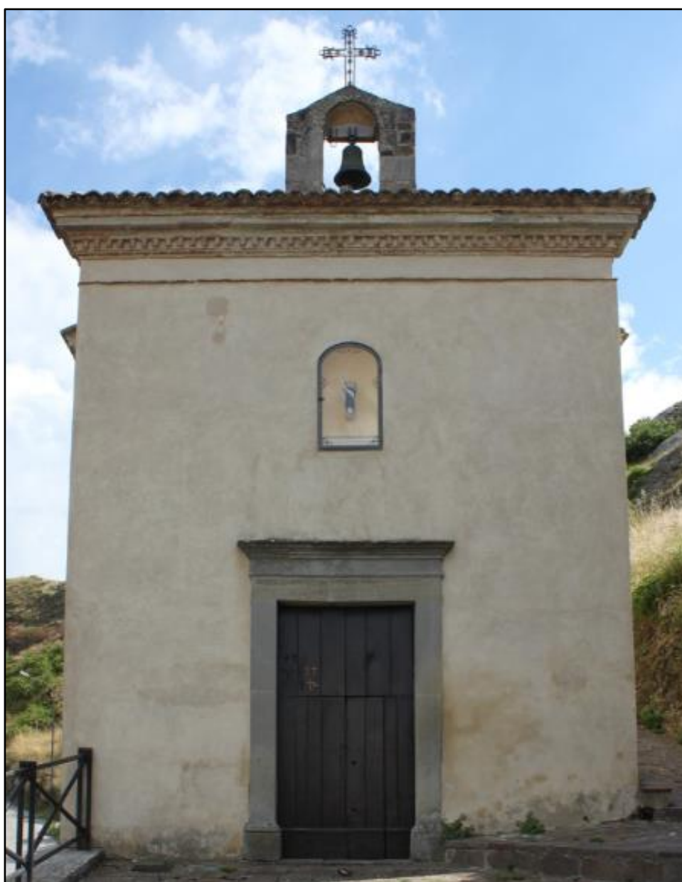
Figura 4.5.7: Chiesa di San Vincenzo Ferreri
