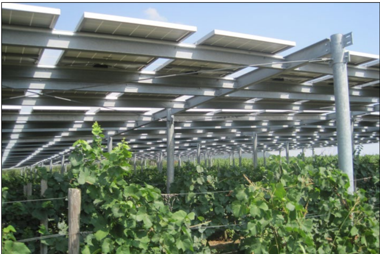
Figura 7-7: Esempio di struttura di sostegno fissa a tettoia (canopy)
