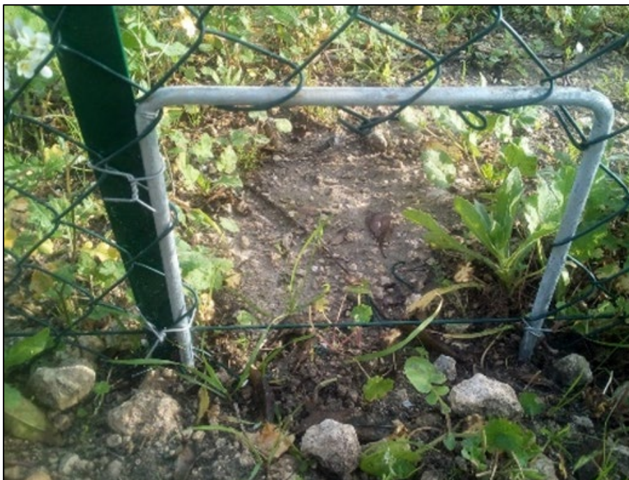
Figura 15-15: Particolare dei passaggi fauna
