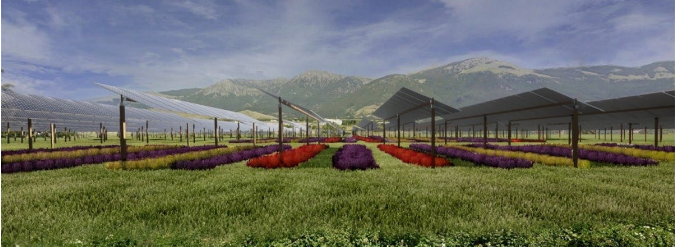
Figura 11. Scorcio di un impianto agrivoltaico generico
