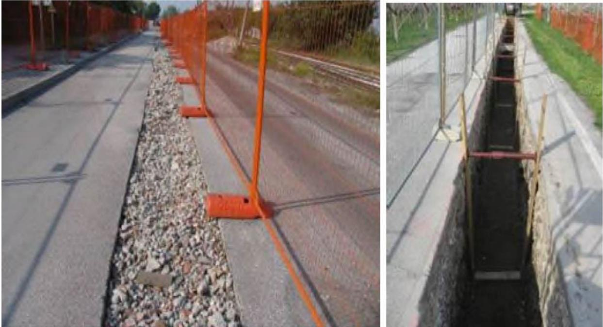
**Figura 4-11: Taglio dell'asfaltatura e scavo aperto.**
