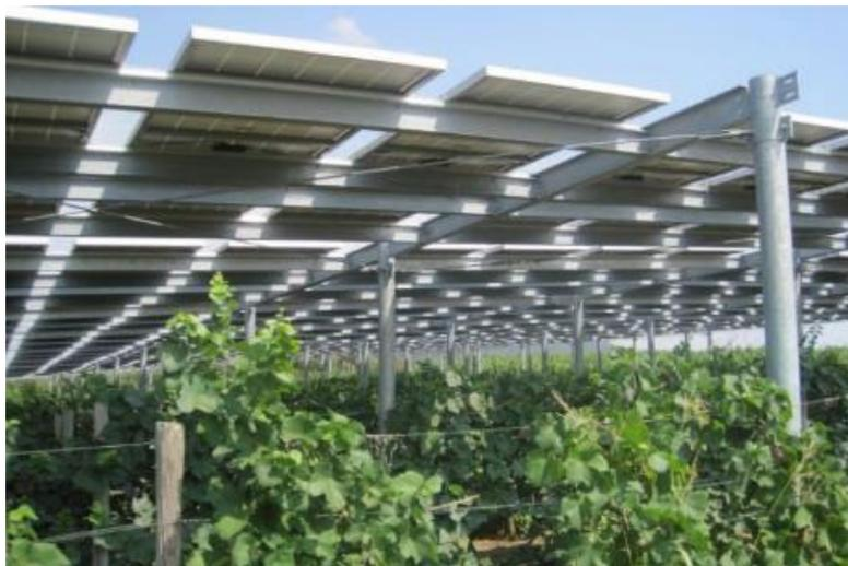
**Figura 4-19: Immagine tipologica di struttura di sostegno fissa a tettoia (canopy). Localizzazione Lotto A, sottocampo 12\*.**
