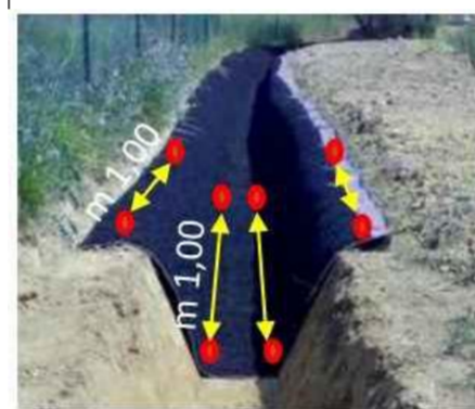
Dettagli di posa e costruzione della trincea drenante dim. cm 80x80
