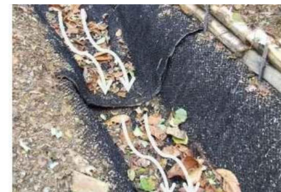
Dettagli di posa e costruzione della trincea drenante dim. cm 80x80
