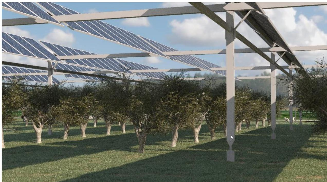
Il progetto che si propone è un vero e proprio impianto agricolo integrato con pannelli fotovoltaici
