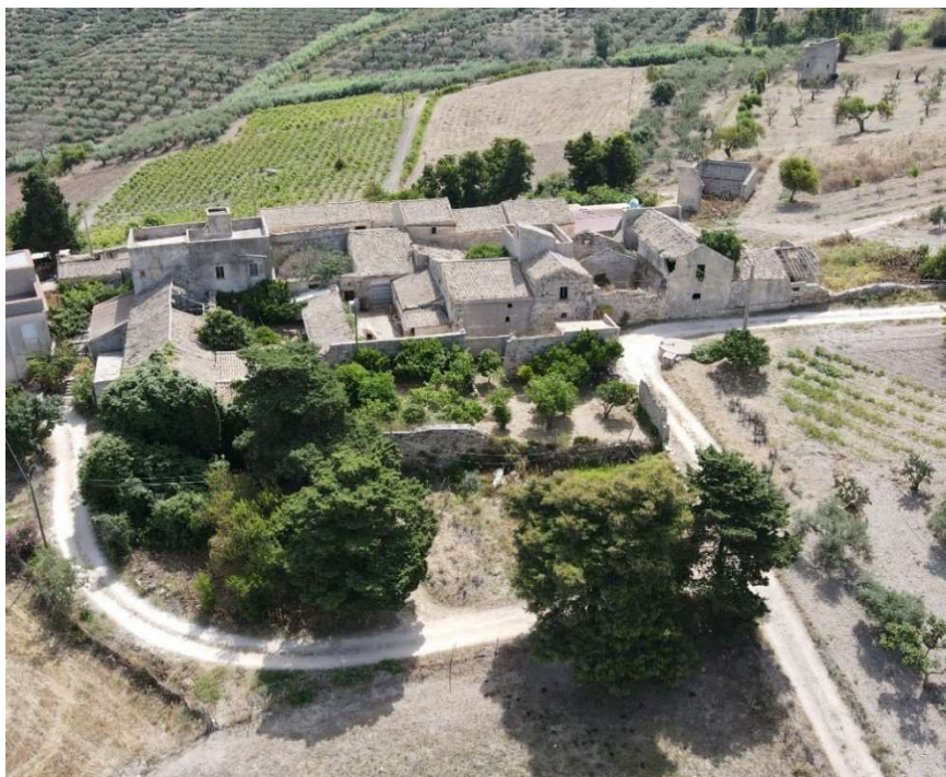
Figura 28. Bene Isolato Baglio Croce - censito come A04, C02 e F02 Unità collabente (foto aerea)
