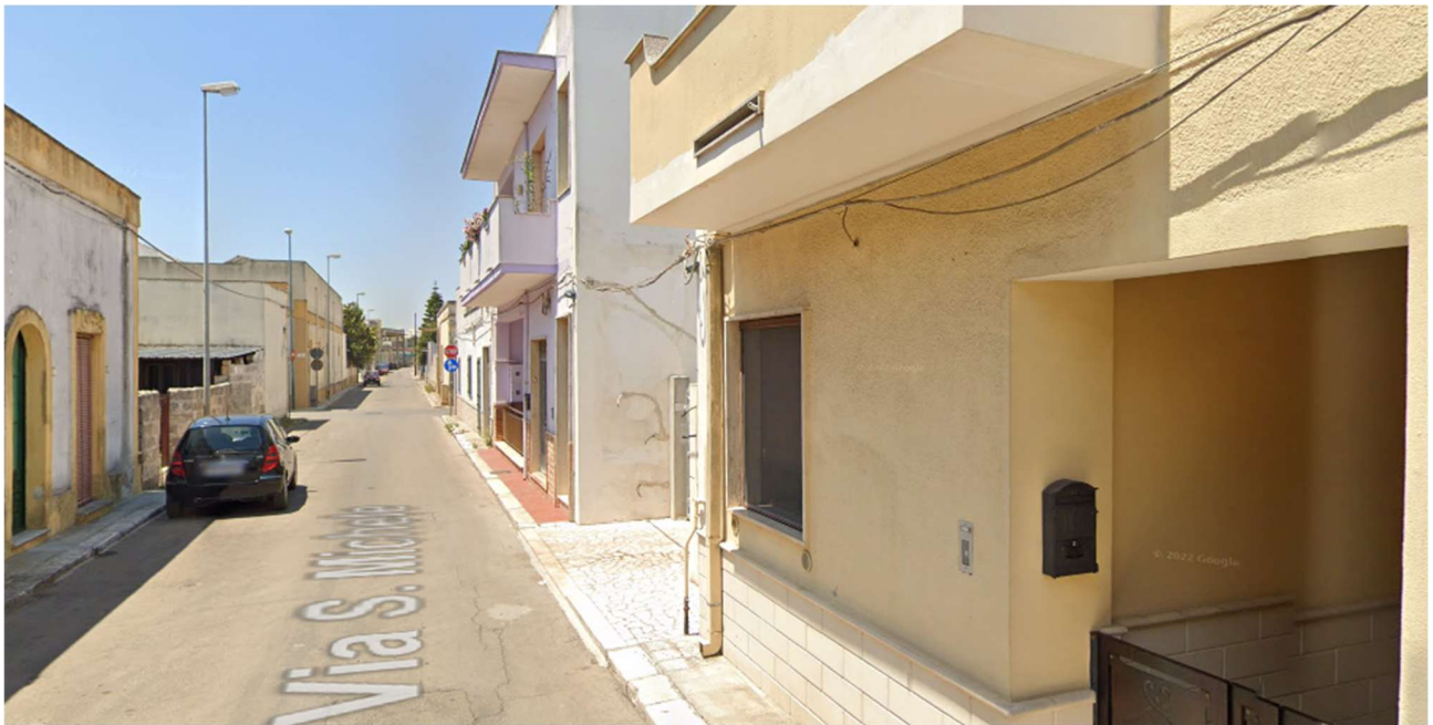
Figure 10 - Punto di osservazione 10 – Città consolidata Cellino San Marco
