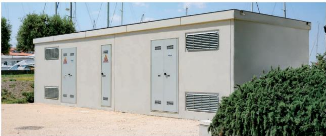
Cabina Prefabbricata installata
