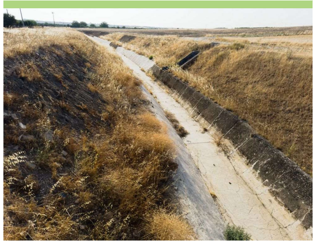
Foto 10. Canali che attraversano l'area di progetto.
